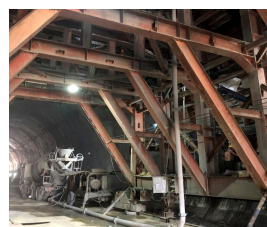
(e) 浇筑混凝土
