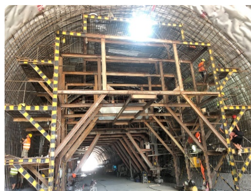
(a) 安装自感知 FRP 筋
