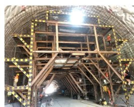
(c) 安装 FRP 筋
